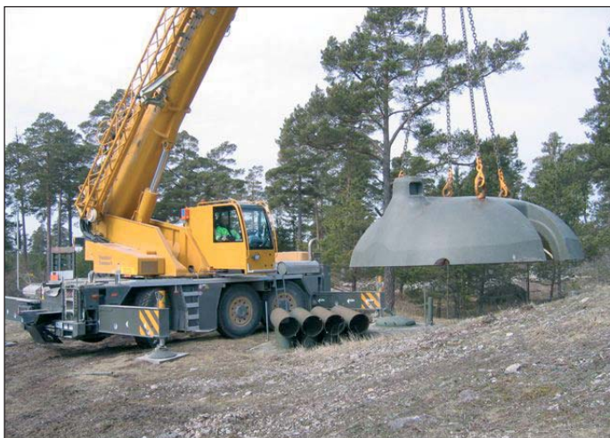
Kupolen är lossad och lyfts till flyttbilen för transport till museiparken.
