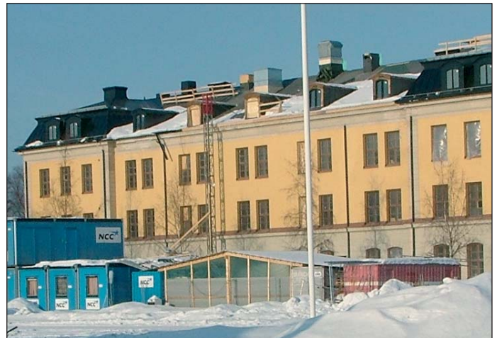
Byggarbetsplats Artilleriregementet! Förutom en av regementets två kaserner syns även det färdigrenoverade kanslihuset längst till vänster. Man kan ju undra vad en gammal S 3:are tycker om detta!
