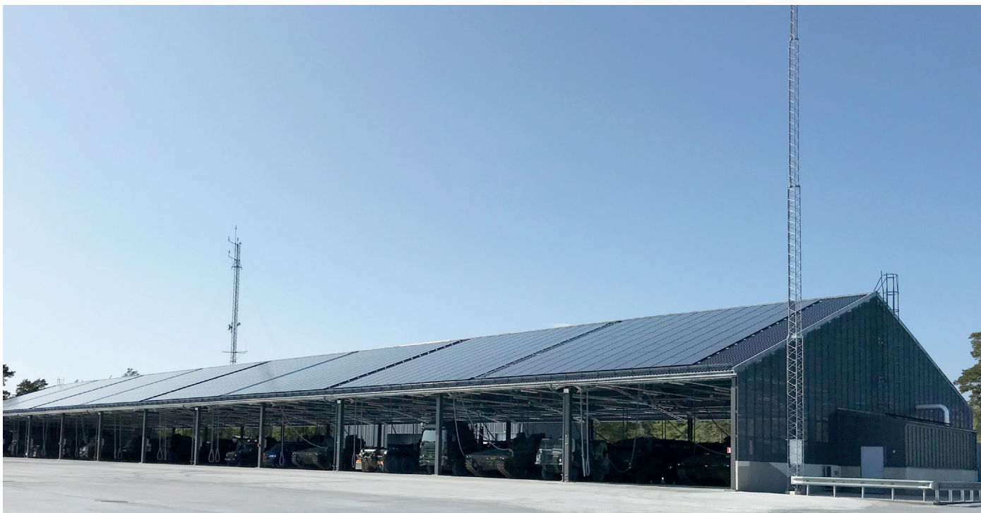
En av Gotlands största solenergianläggningar finns på taken till de två stolpladorna. Regementsområdet blir i stort sett självförsörjande på el.
